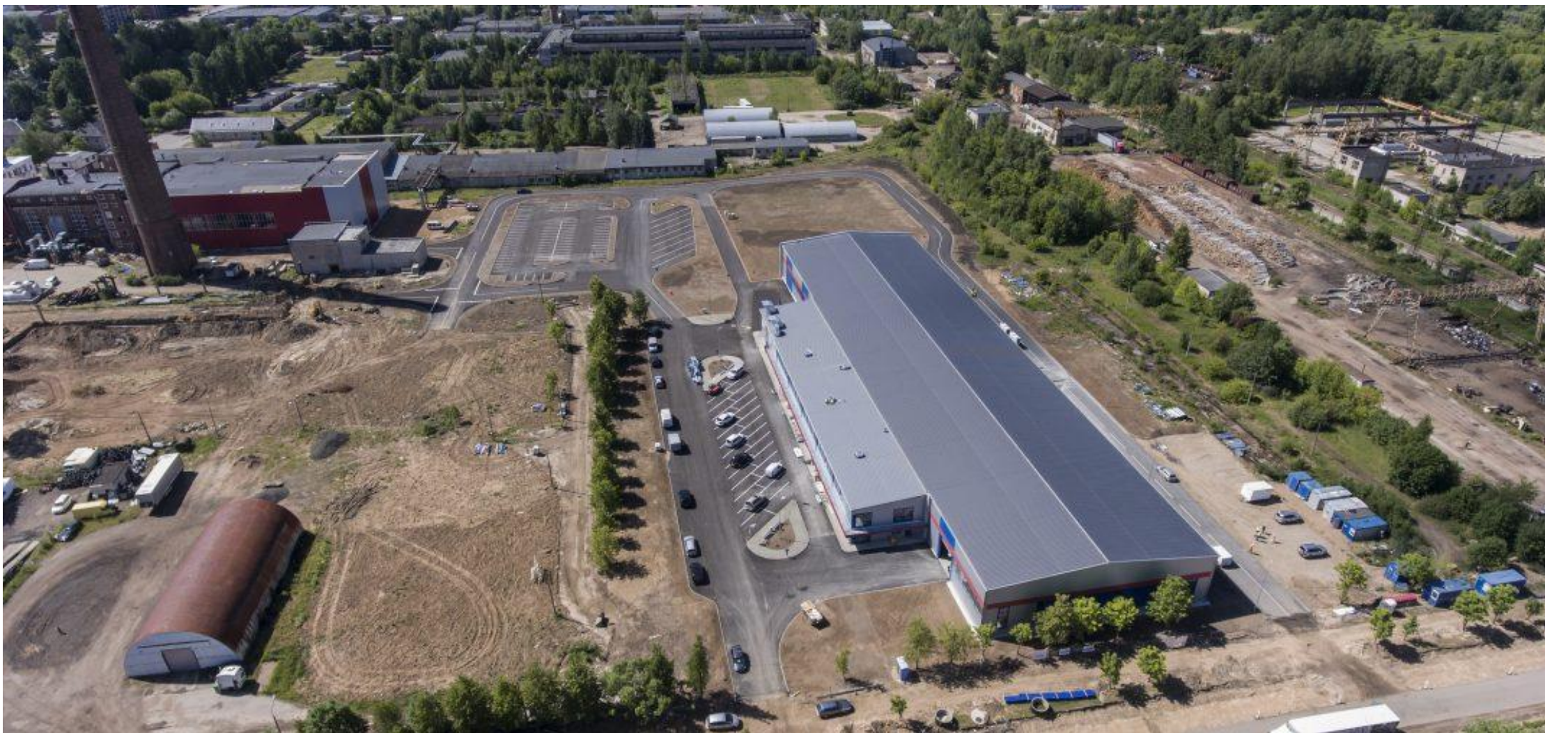
Rūpniecības kompleksa ar ražošanas korpusu, administratīvo – sadzīves ēku, palīgtelpām, tehniskajām telpām un piebraucamā ceļa būvniecība Rēzeknē
