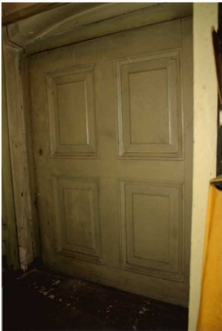
39. fotoattēls. L tipa durvis (1909.gads) ar sākotnējo aprīkojumu.
