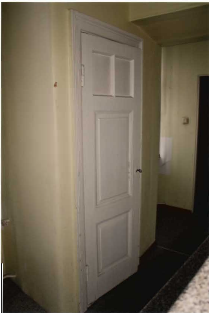
33. fotoattēls. F tipa durvis (1909.gads) ar sākotnējām seglīstēm un aprīkojumu.
