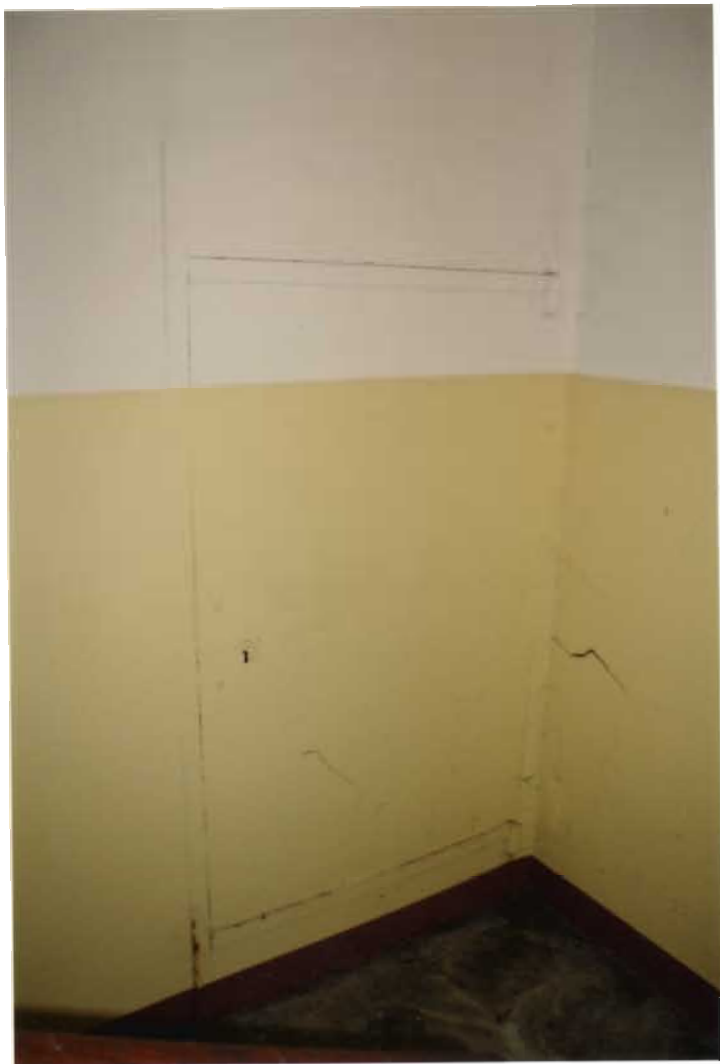
45. fotoattēls. R tipa metāla durvis (1909.gads) ar sākotnējo aprīkojumu.
