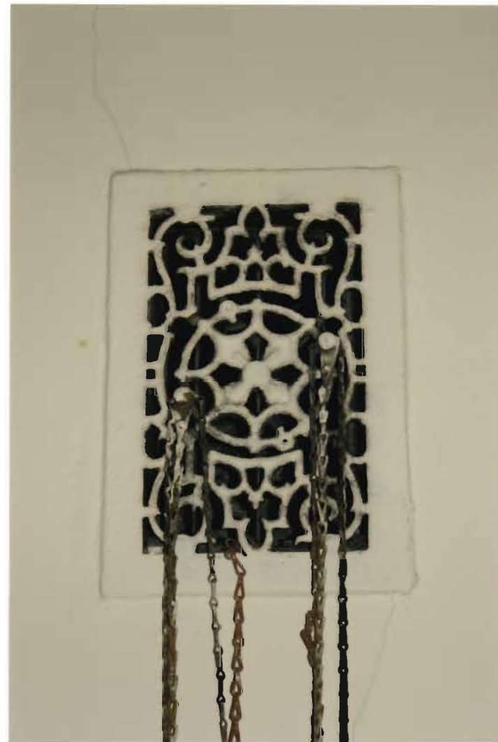
88. fotoattēls. Sākotnēja (1909.gads) ventilācijas reste telpā T203
