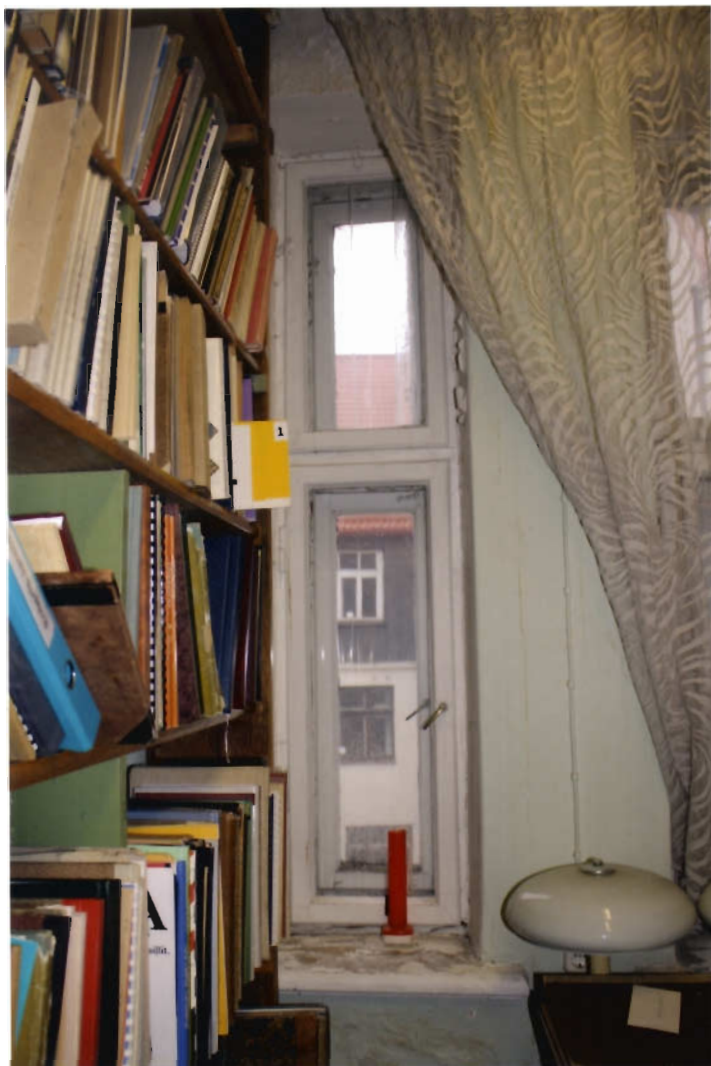
21. fotoattēls. 15.tipa logs (1929.gads) ar oriģinālo aprīkojumu.
