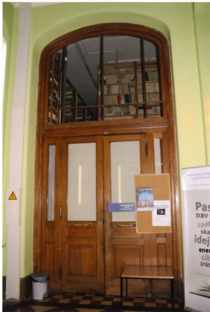
27. fotoattēls. A tipa durvis (1909.gads) ar sākotnējo aprīkojumu un seglistēm.
