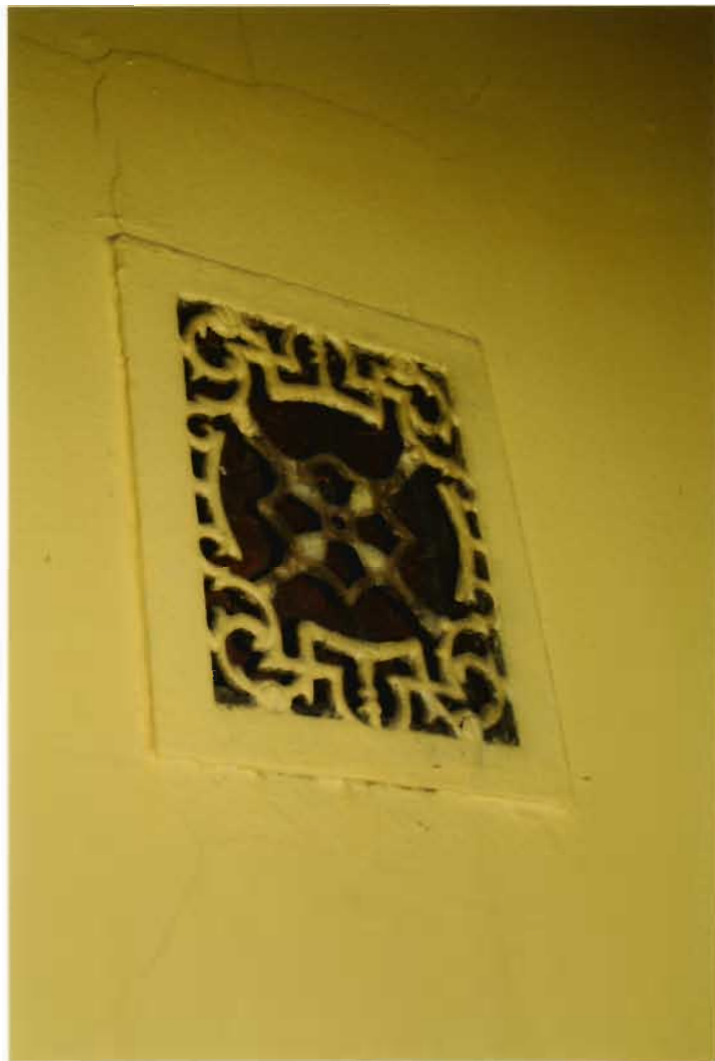
87. fotoattēls. Sākotnēja (1909.gads) ventilācijas reste telpā T106.
