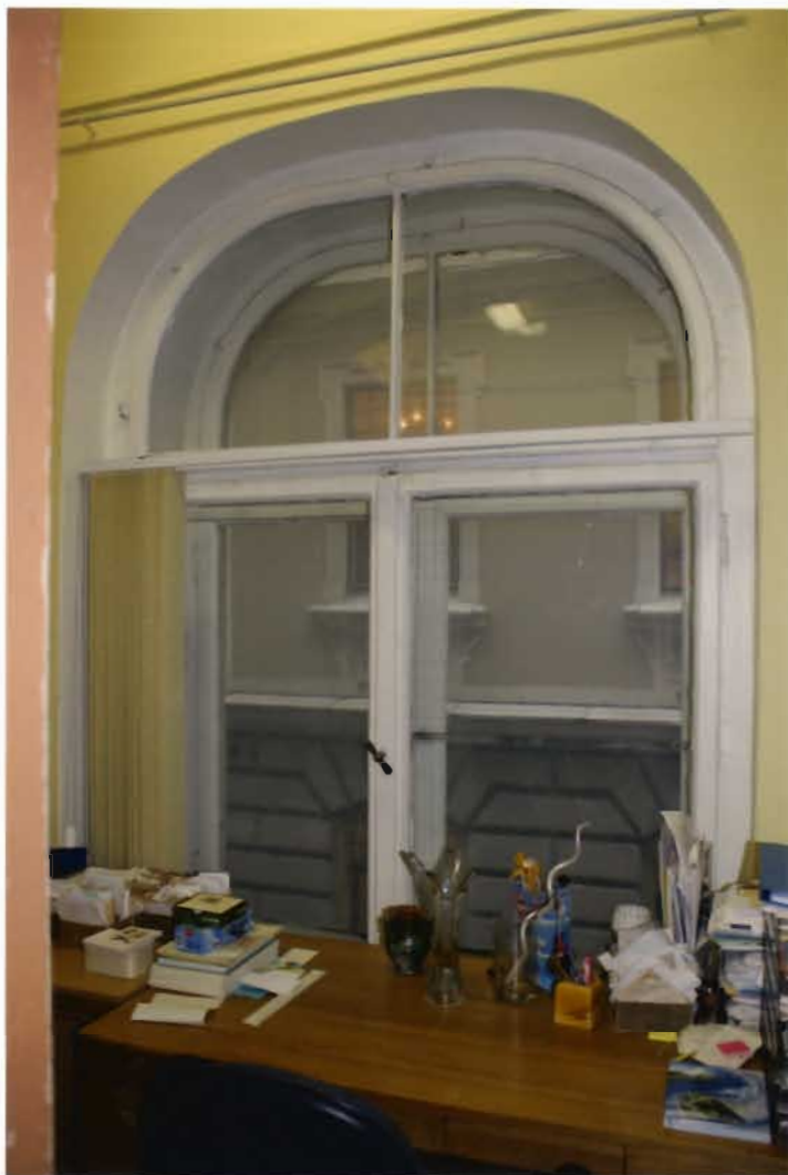
11. fotoattēls. 5.tipa logs (1909.gads) ar sākotnējo aprīkojumu.
