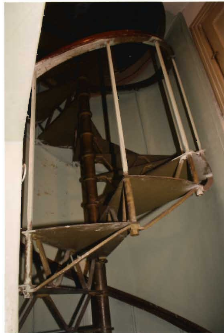
72. fotoattēls. Sākotnējas (1909.gads) metāla vītņu kāpnes starp telpām T027 un T103.
