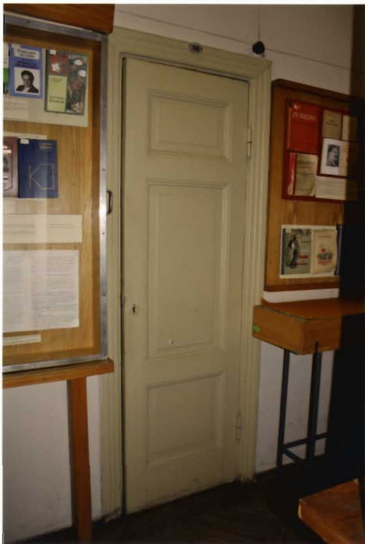
37. fotoattēls. J tipa durvis (1929.gads) ar oriģinālajām seglīstēm un aprīkojumu.
