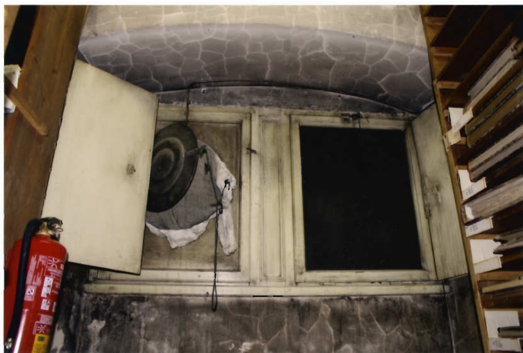
22. fotoattēls. 16.tipa logi (1909.gads) ar sākotnējo aprīkojumu un metāla slēgiem.
