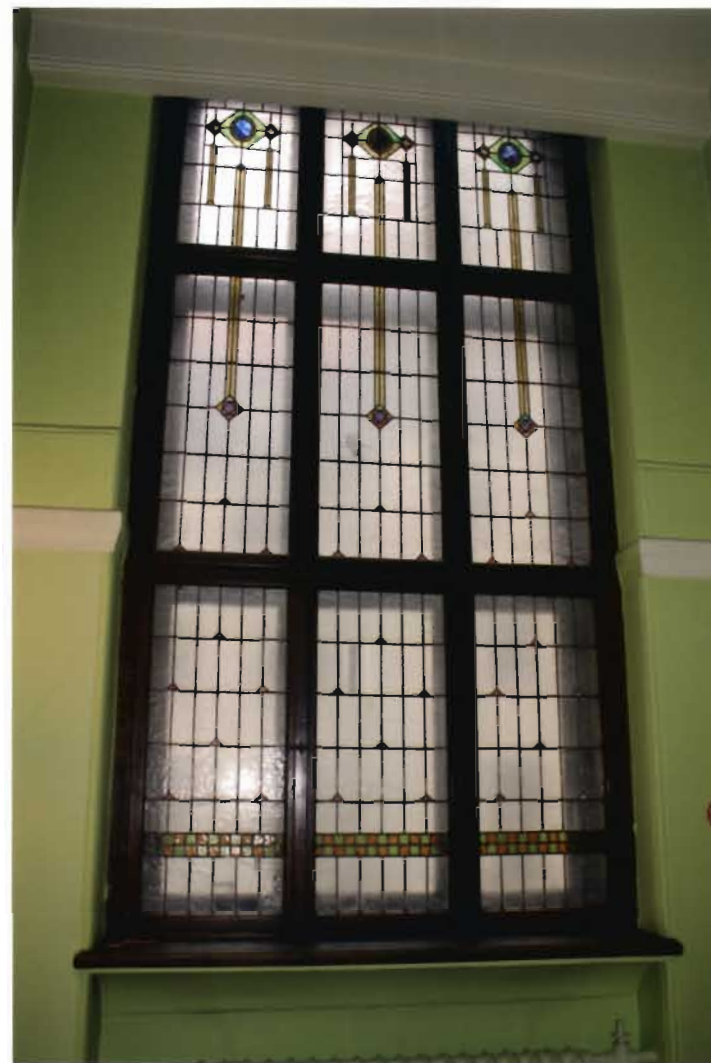
10. fotoattēls. 4.tipa logs (1909.gads) ar sākotnējo vitrāžu un aprīkojumu.
