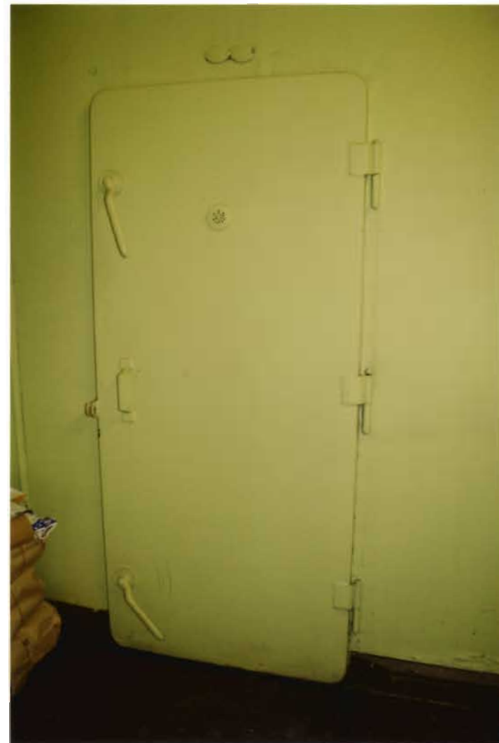
46. fotoattēls. S tipa metāla durvis (1940.gads) ar sākotnējo aprīkojumu.
