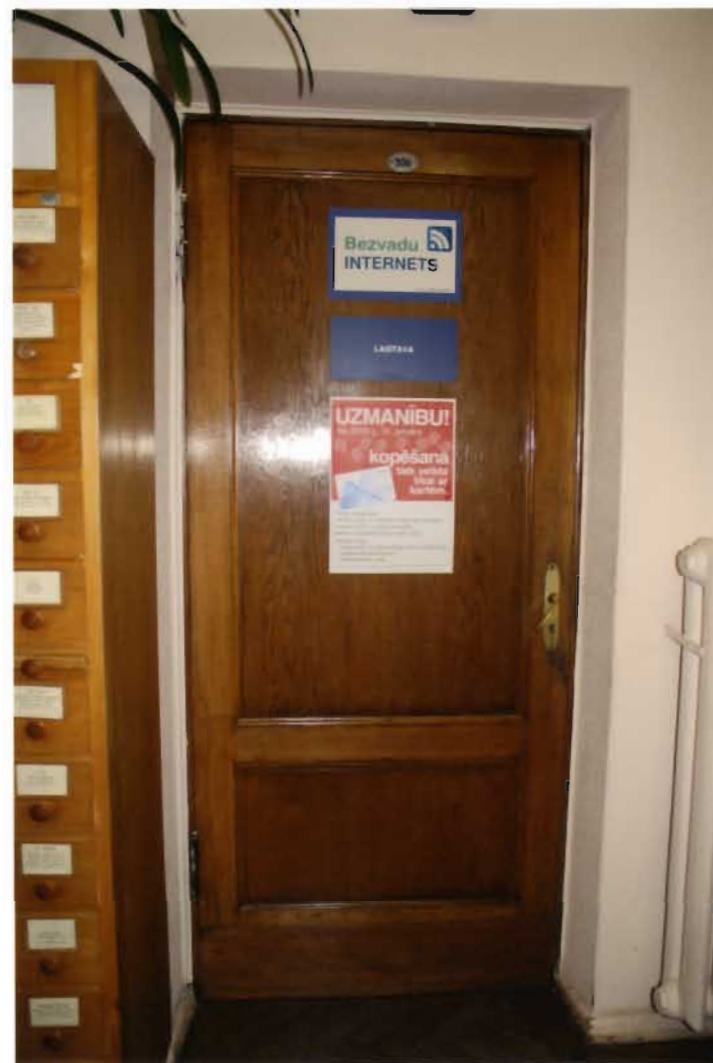
38. fotoattēls. K tipa durvis (1929.gads) ar oriģinālo aprīkojumu.
