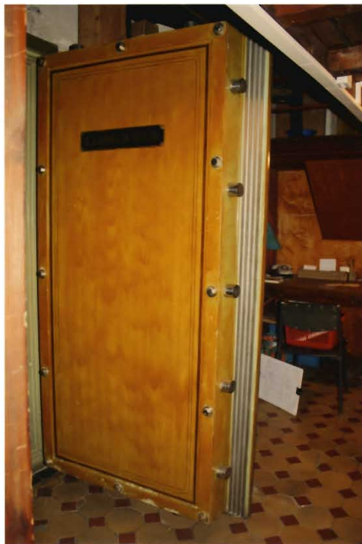
44. fotoattēls. P tipa metāla durvis (1909.gads) ar sākotnējo aprīkojumu un krāsojumu.
