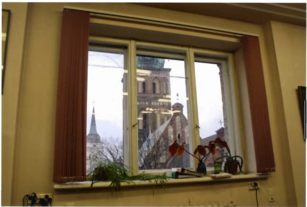
15. fotoattēls. 9.tipa logs (1929.gads) ar oriģinālo aprīkojumu.
