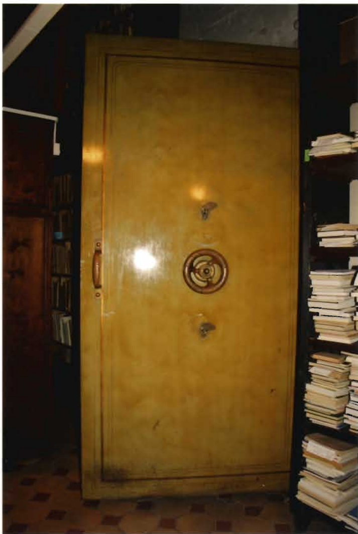
43. fotoattēls. P tipa metāla durvis (1909.gads) ar sākotnējo aprīkojumu un krāsojumu.
