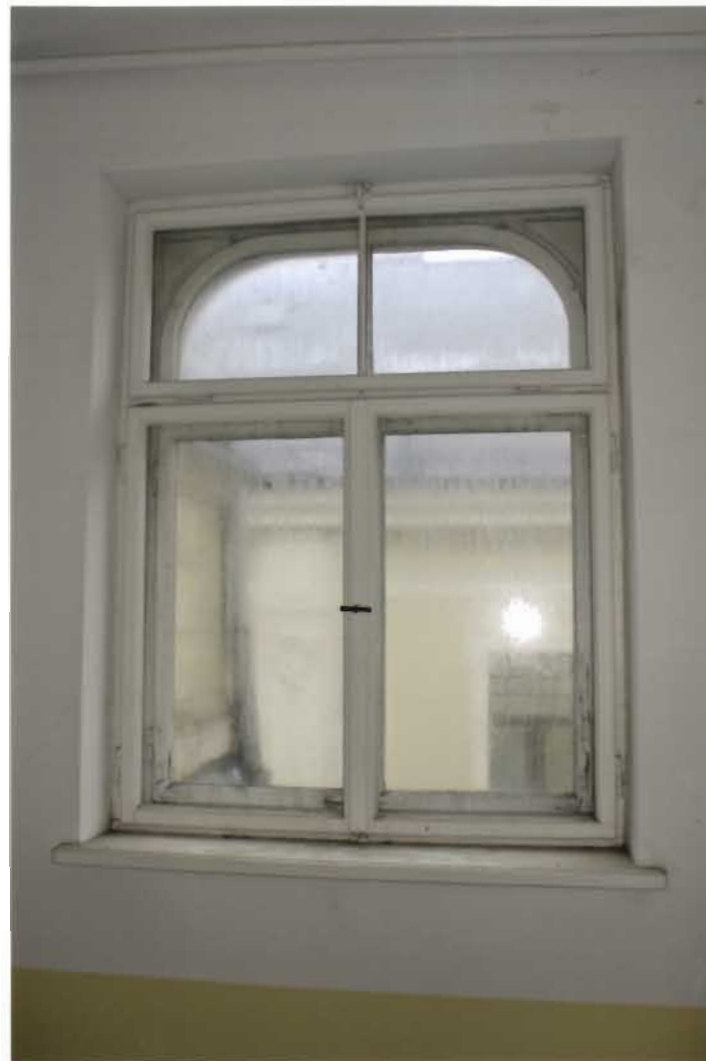
12. fotoattēls. 6.tipa logs (1909.gads) ar sākotnējo aprīkojumu.
