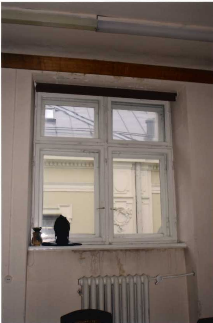
18. fotoattēls 12.tipa logs (1929.gads) ar oriģinālo aprīkojumu.
