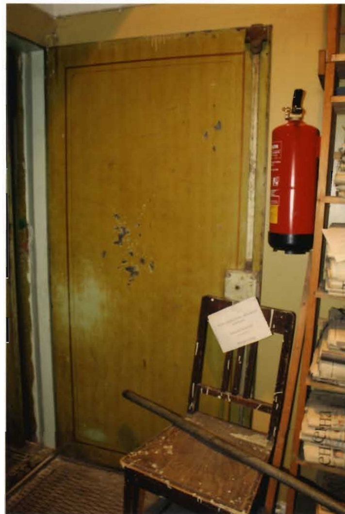
42. fotoattēls. O tipa metāla durvis (1909.gads) ar sākotnējo aprīkojumu un krāsojumu.
