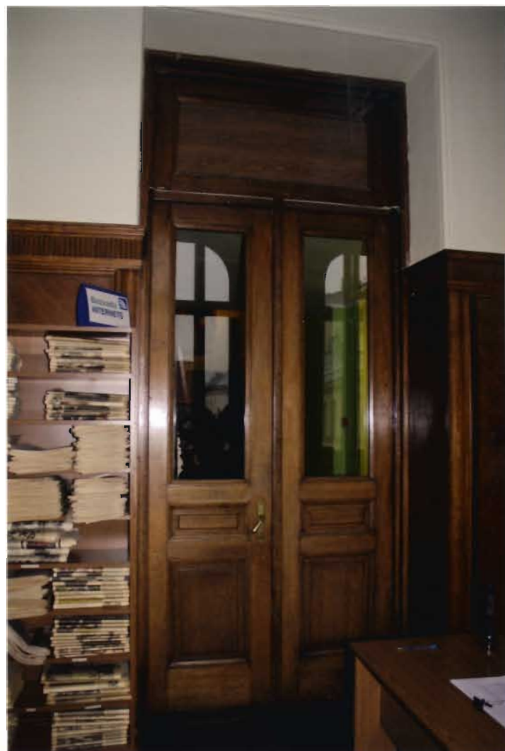
28. fotoattēls. B tipa durvis (1909.gads) ar sākotnējo aprīkojumu. Virsgaismā likvidēts stiklojums.
