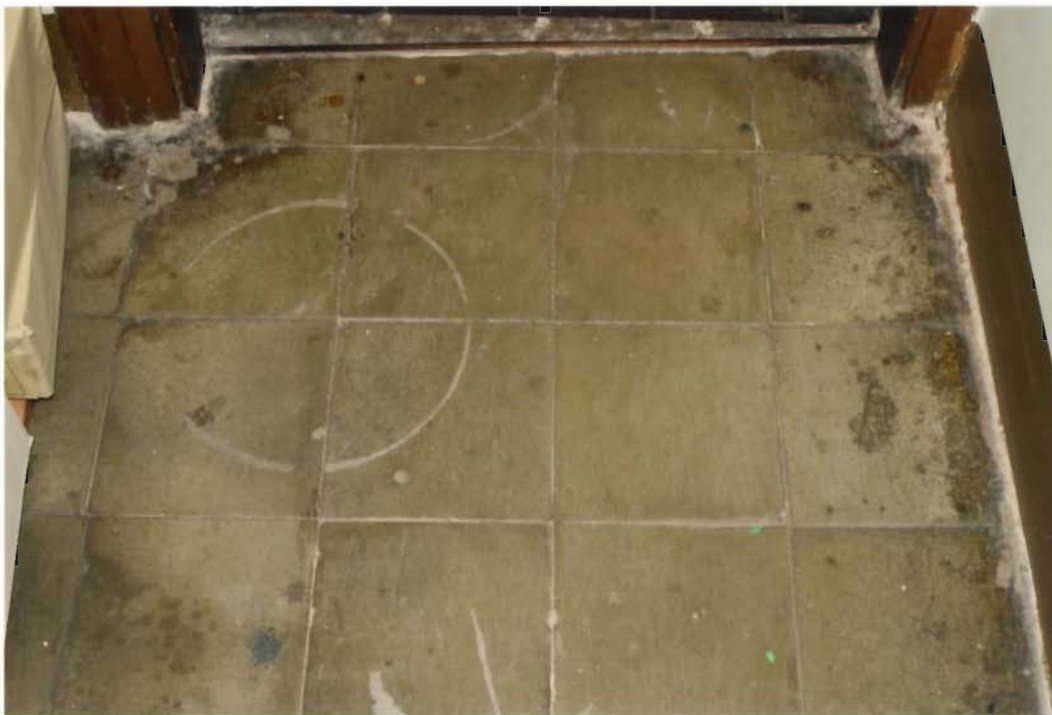
59. fotoattēls. 9.tipa grīdas flīžu ieklājums (1929.gads).
