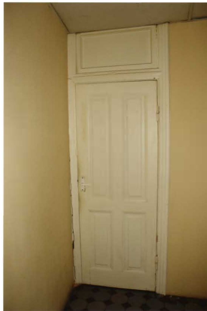
36. fotoattēls. I tipa durvis (1929.gads) ar oriģinālajām seglīstēm un virslogu.
