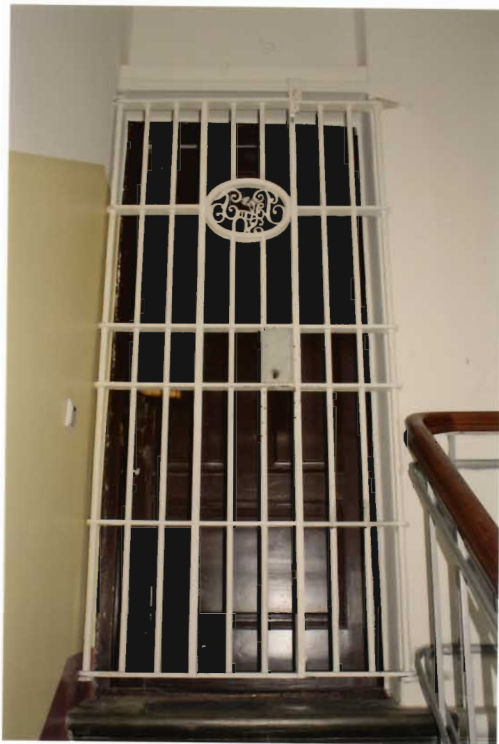
47. fotoattēls. Sākotnējās durvis (1909.gads), kas veidotas kā metāla restes.
