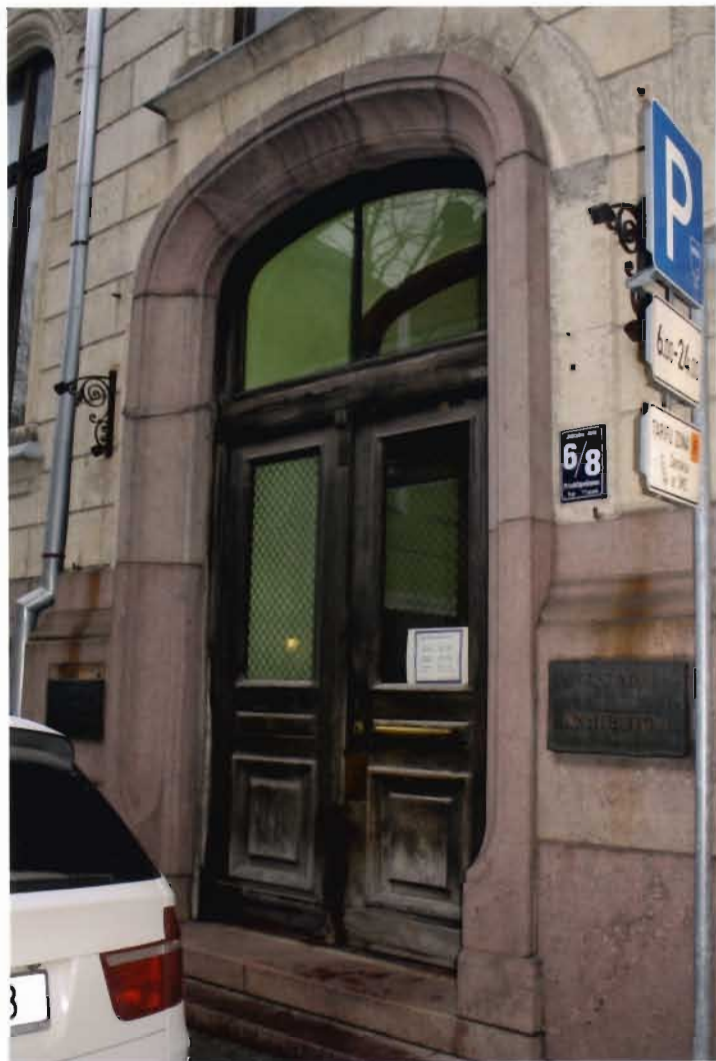
25. fotoattēls. Galvenās ieejas durvis (1909.gads) ar sākotnējo aprīkojumu. Stiklotajā daļā zudušas oriģinālās metālkaluma restes.
