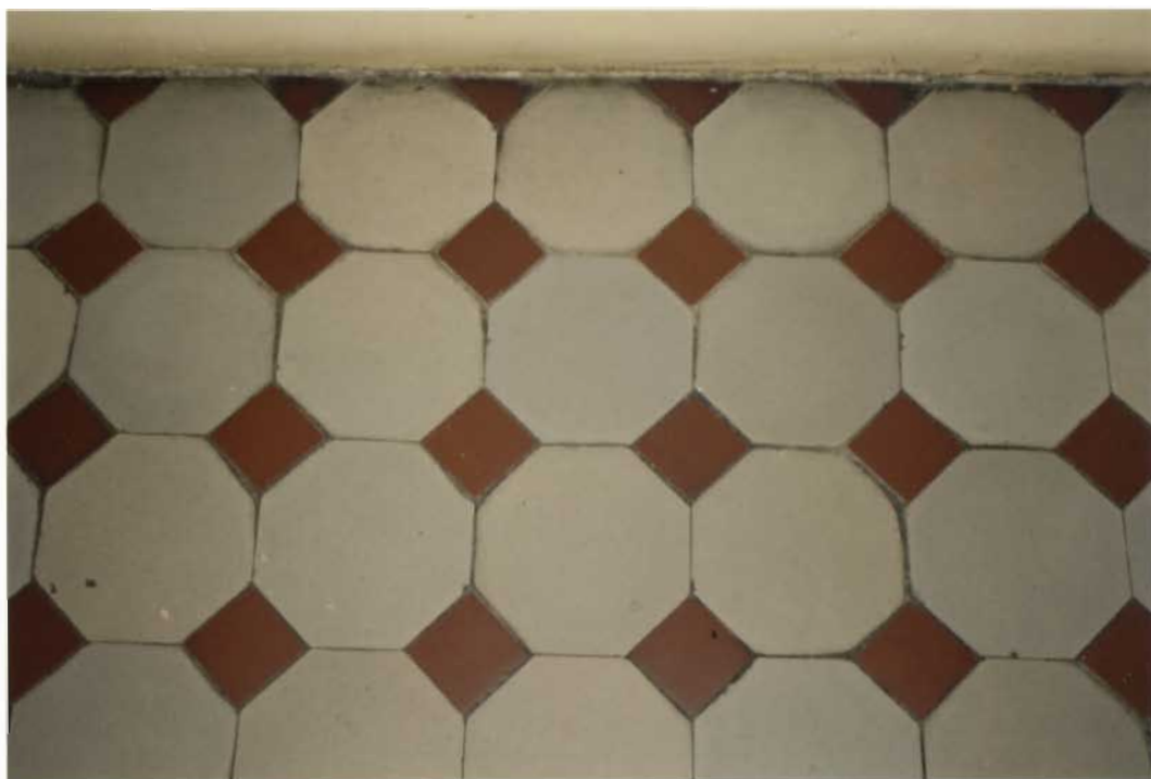
58. fotoattēls. 8.tipa grīdas flīžu ieklājums (1929.gads).
