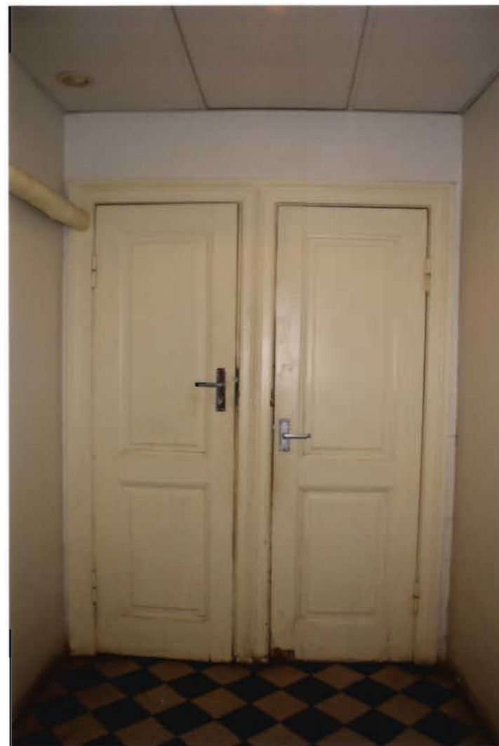
32. fotoattēls. E tipa durvis (1909.gads) ar sākotnējām seglīstēm.
