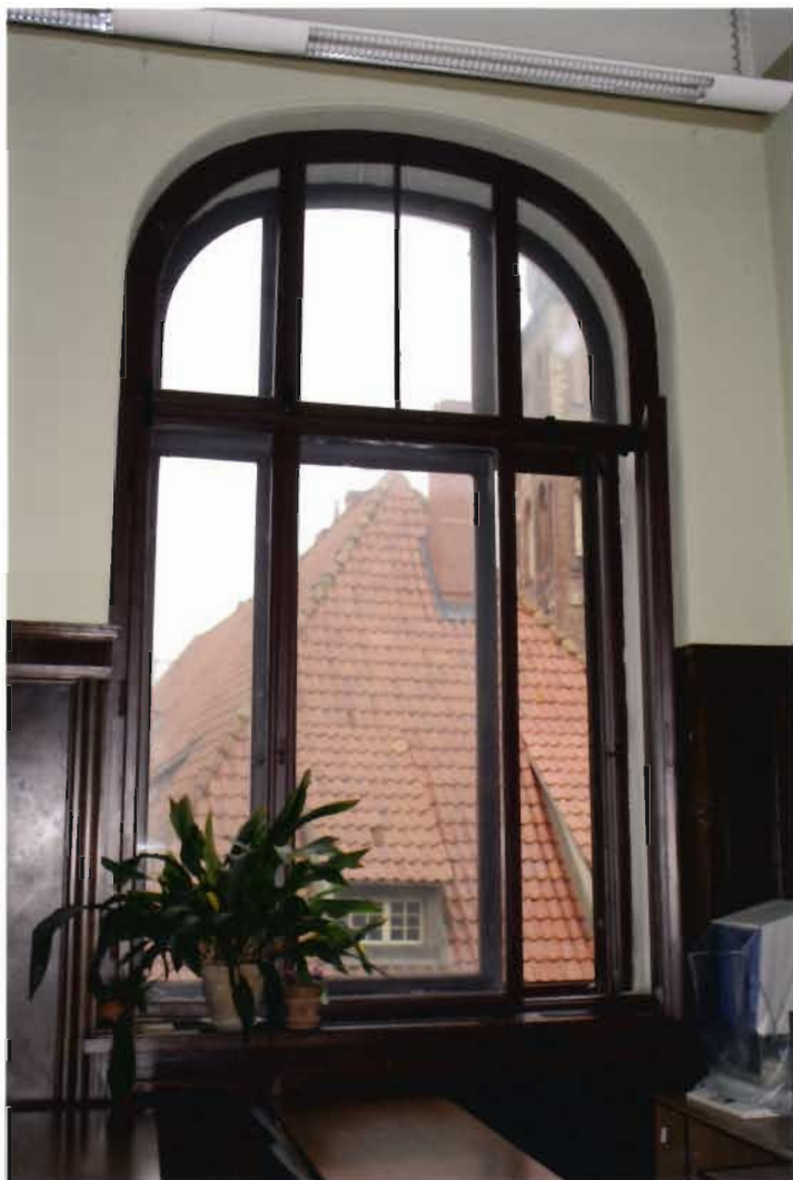
7. fotoattēls. 2.tipa logs (1909.gads) ar sākotnējo aprīkojumu.
