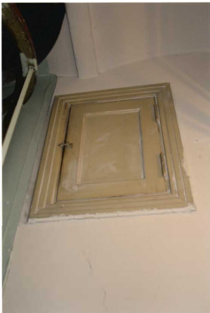
41. fotoattēls. N tipa durvis (1940.gads) ar oriģinālajām seglīstēm un aprīkojumu.
