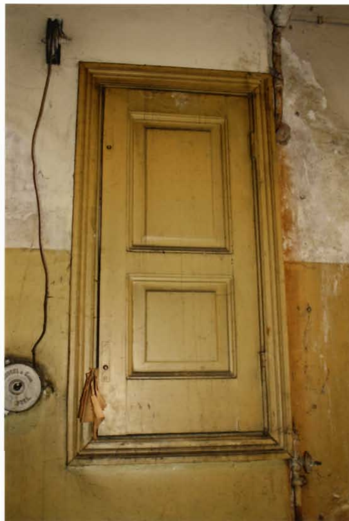
40. fotoattēls. M tipa durvis (1909.gads) ar sākotnējām seglīstēm un aprīkojumu.
