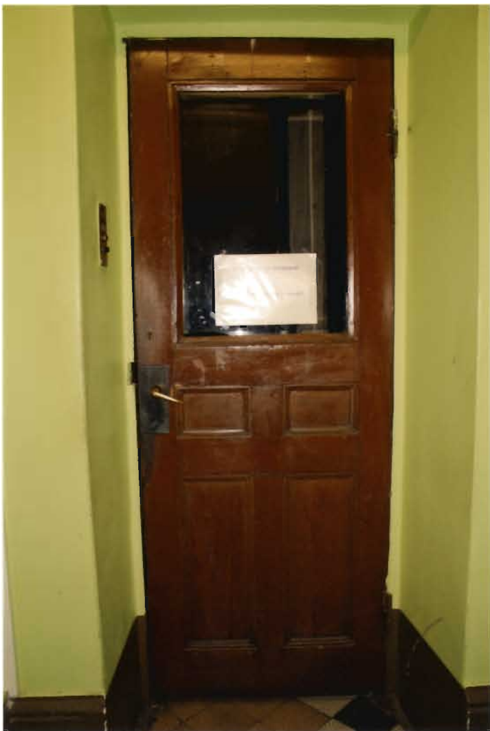
35. fotoattēls. H tipa durvis (ieejai liftā, 1929.gads) ar oriģinālo aprīkojumu.
