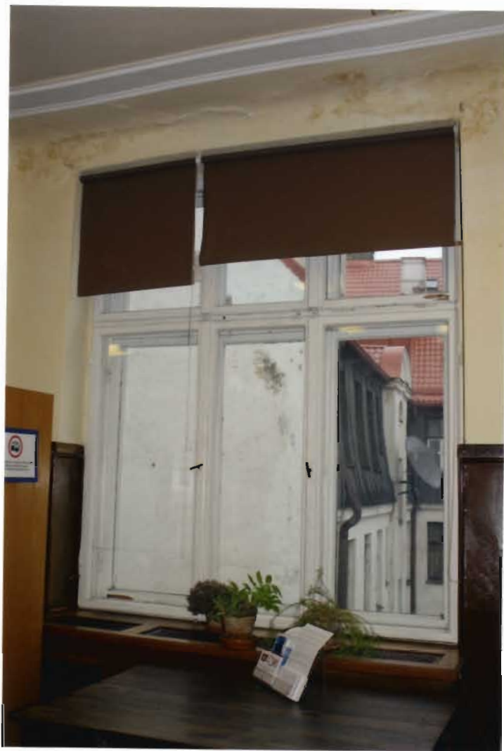
9. fotoattēls. 3'.tipa logs (1929.gads) ar oriģinālo aprīkojumu.
