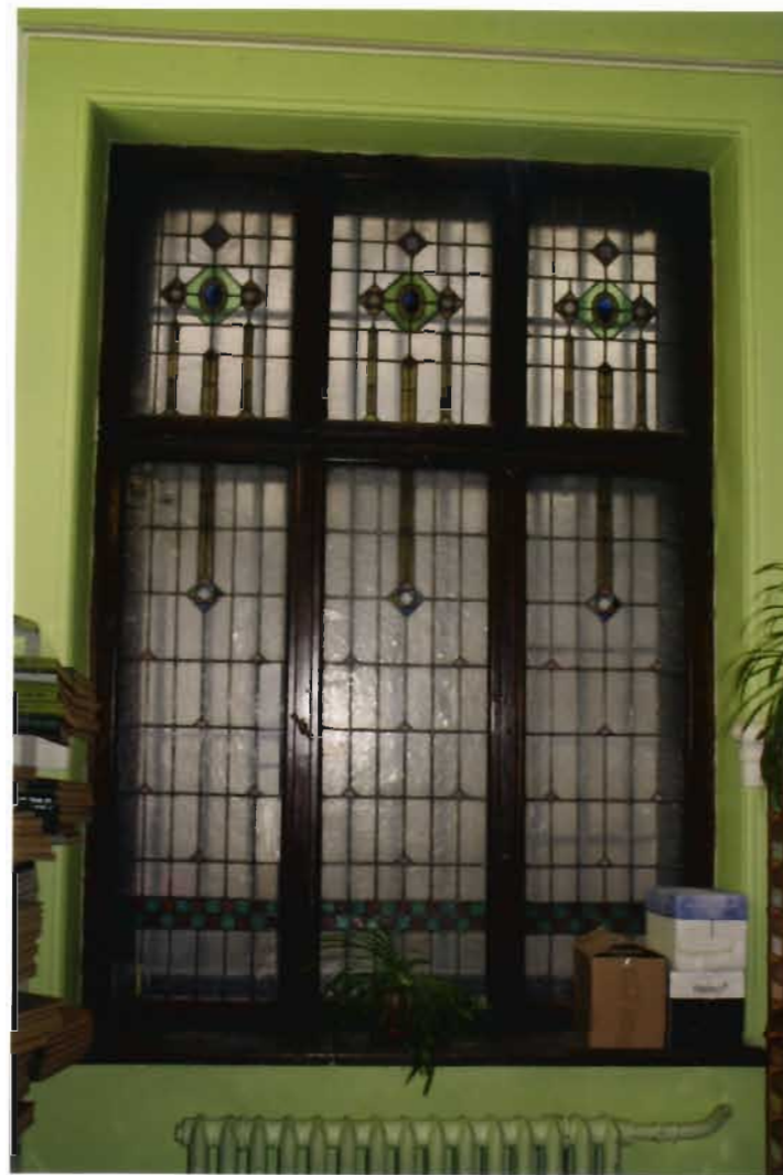
8. fotoattēls. 3.tipa logs (1909.gads) ar sākotnējo vitrāžu un aprīkojumu.
