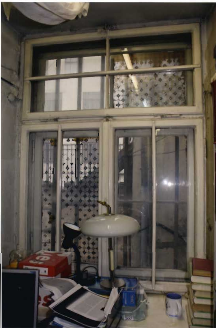
16. fotoattēls 10.tipa logs (1909.gads) ar sākotnējo aprīkojumu un daļēji saglabājušos sākotnējo dekoratīvā papīra aplikāciju.
