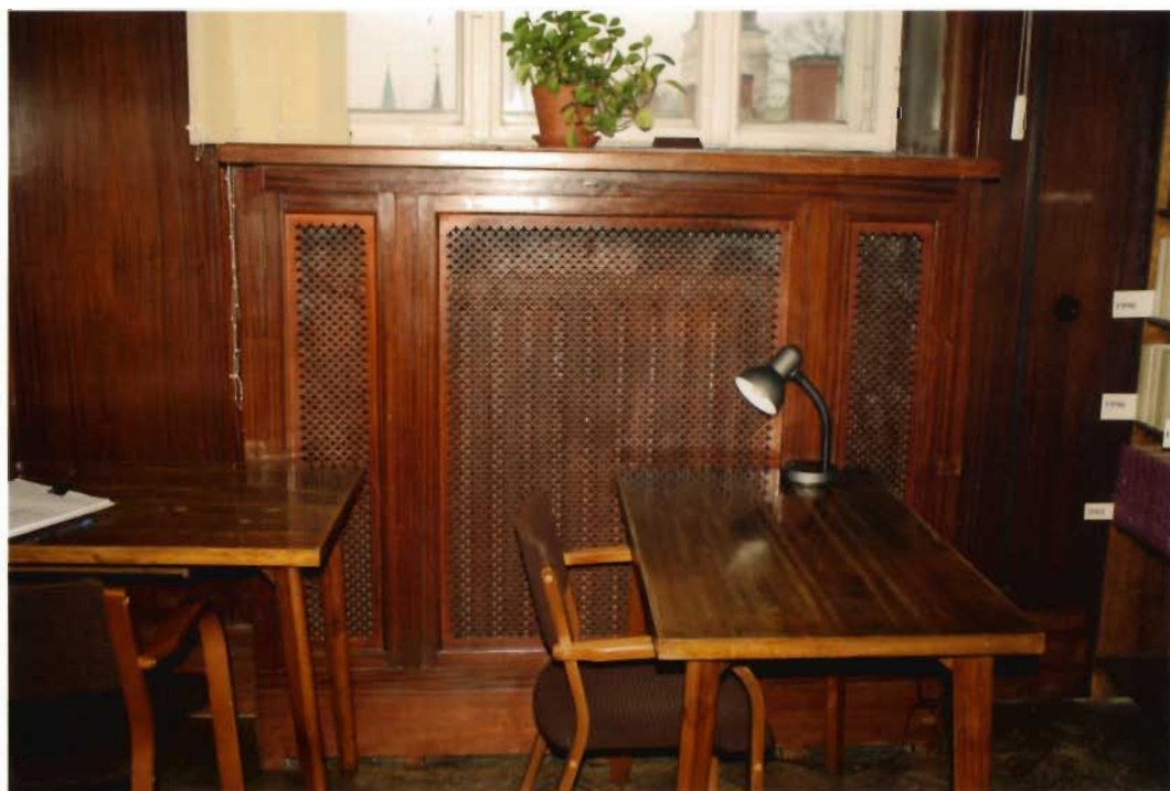
66. fotoattēls. Dekoratīvs radiatoru nosegrežģis telpā T309 (1936.gads).
