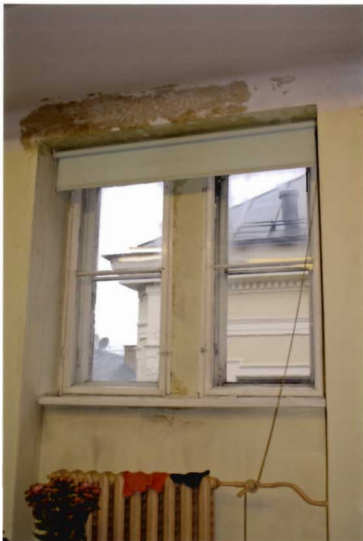
19. fotoattēls. 13.tipa logi (1929.gads) ar oriģinālo aprīkojumu.
