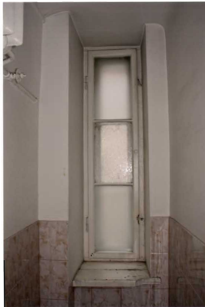
20. fotoattēls. 14.tipa logs (1909.gads) ar sākotnējo aprīkojumu.
